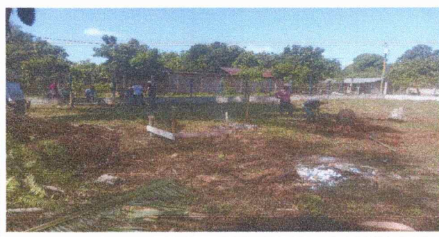
Foto 2: Previo donde se iniciara la construcción de 3 aula
